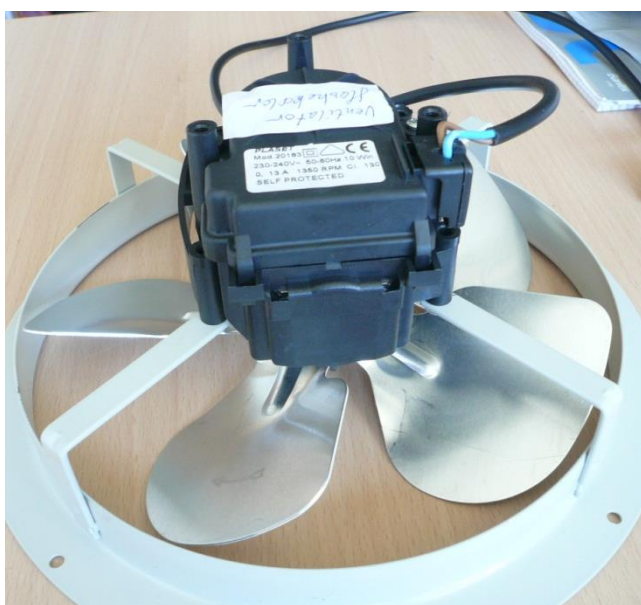
Figur 9-15 Fordamperventilator til flaskekøler
