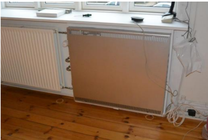
Fig 1.6. 5 Udført vinduesintegreret ventilation med varmegenvinding i P. Knudsens Gade i Sydhavnen, København
