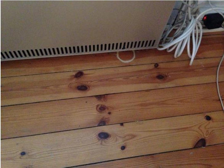
Fig 1.6. 11 Foto af boret hul i gulvet ifm tætning af træbjælkedæk langs facaden vha. indblæst papiruld
