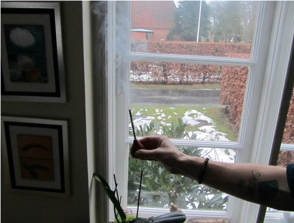
Fig 1.7. 17 Check af utætheder ved vinduer i Sorø ifm BlowerDoor test
