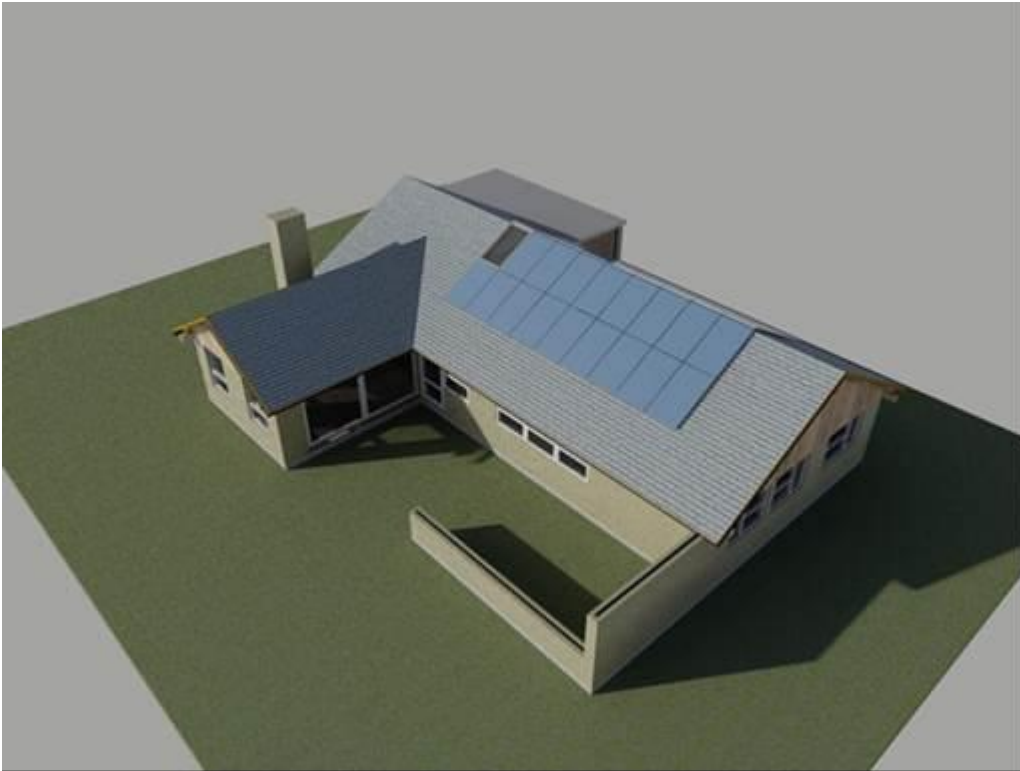
Fig 1.7. 1 Tegning af 1960'er parcelhus med skråt tag i Albertslund med solprisme løsning i form af VELUX vindue og solceller, som blev energirenoveret i 2012. Dette projekt var først tiltænkt Solprisme Task Force, men kom i spil i forbindelse med Albertslund Konceptet, da et andet projekt faldt ud.
