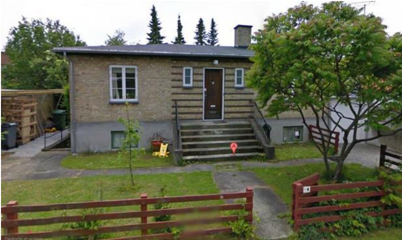
Fig 1.6. 3 Enfamiliehus i Valby før renovering
