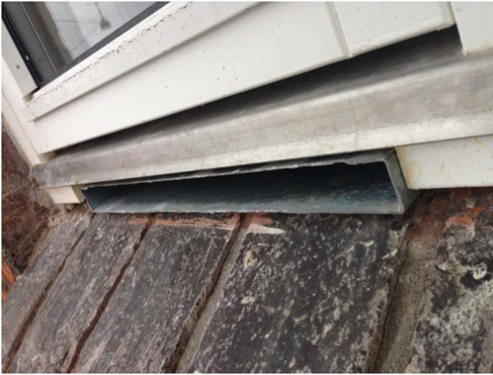
Fig 1.6. 7 De nye vinduer i prøvelejlighed i Sydhavnen blev udført med indpassede ventilationsindtag og afkast i samarbejde med firmaet EVD.
