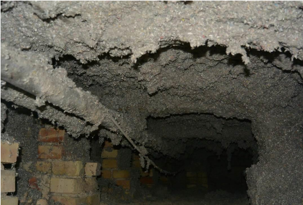
Fig 1.7. 12 Krybekælder under det meste af huset blev isoleret med en særlig form for papiruld med et vist limindhold, så det fæstnede på undersiden af gulvene. (100 -150 mm)
