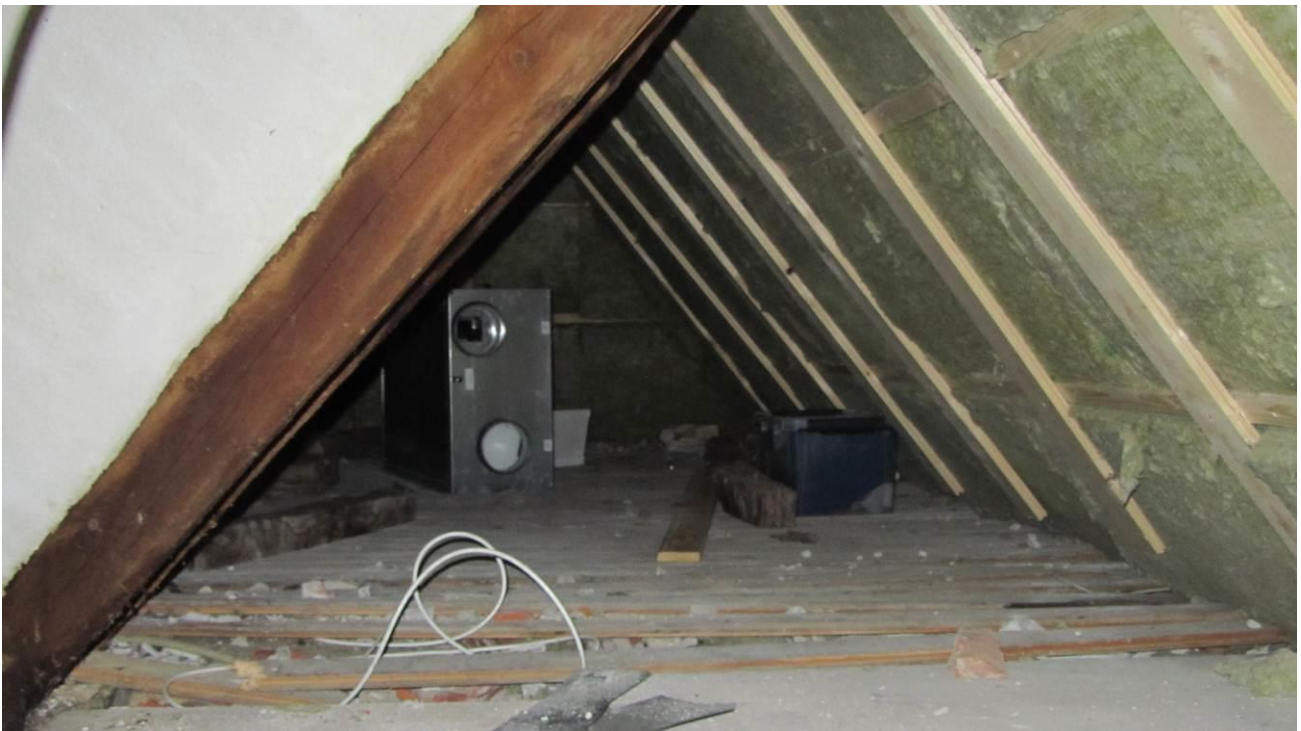
Fig 1.7. 10 EcoVent varmegenvinder aggregat under montage på spidsloft
