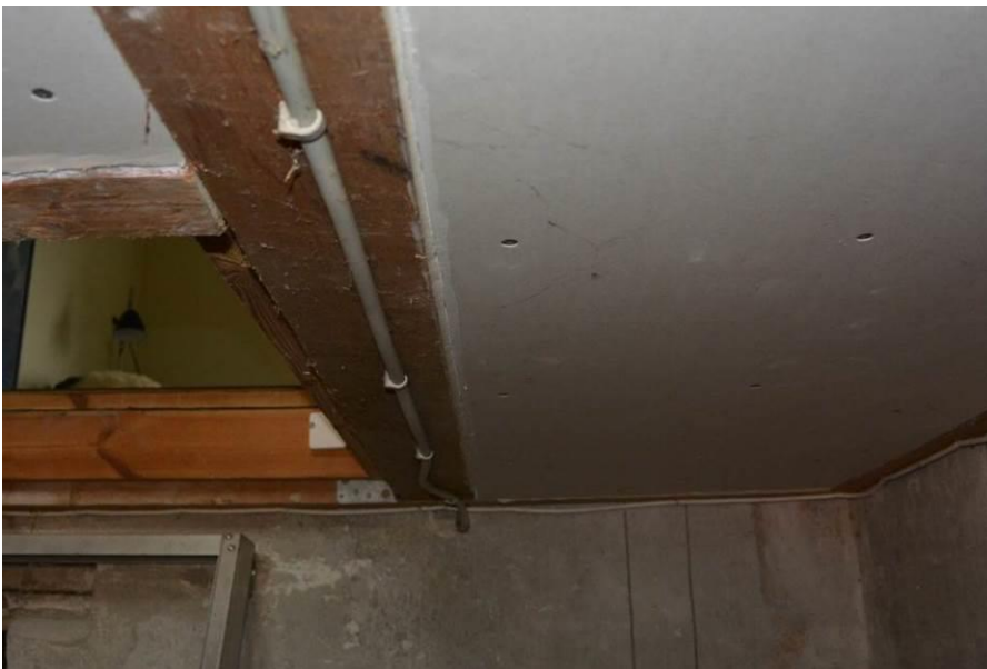
Fig 1.7. 11 Isolering mod kælder under køkkenet. I gammel garage som er blevet isoleret er anvendt indvendig isolering. Der mangler dog gulvisolering her.
