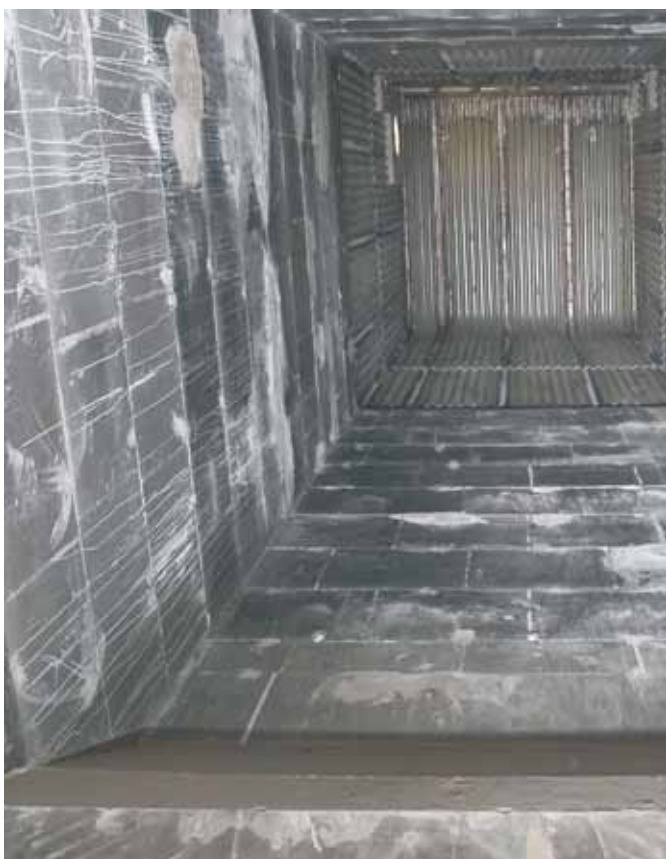
Et kig op i en affaldskedel på Haderslev Kraftvarmeværk, der har fået ny belægning i en flot håndværksmæssig udførelse.
