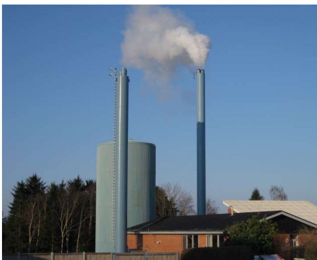
Mindre gasfyret kraftvarmeværk
