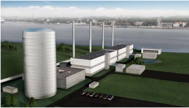
Figur 3 Billedet viser værket i Kiel. Motorerne placeres gruppevis i separate blokke.
