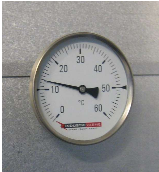
Figur 21 Røggastemperatur efter absorptionsvarmepumpen i Figur 20.
