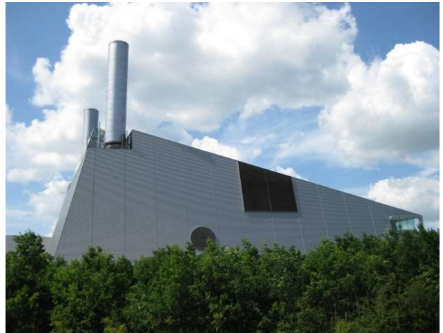
Større decentralt kraftvarme/fjernvarmeværk. Værket råder over gasturbiner, dampturbine, absorptionsvarmepumpe, gaskedler, elkedel samt et stort solvarmeanlæg.
